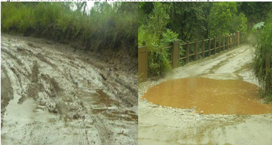
Figura 4 - Realidade das estradas que dão acesso as escolas do campo
