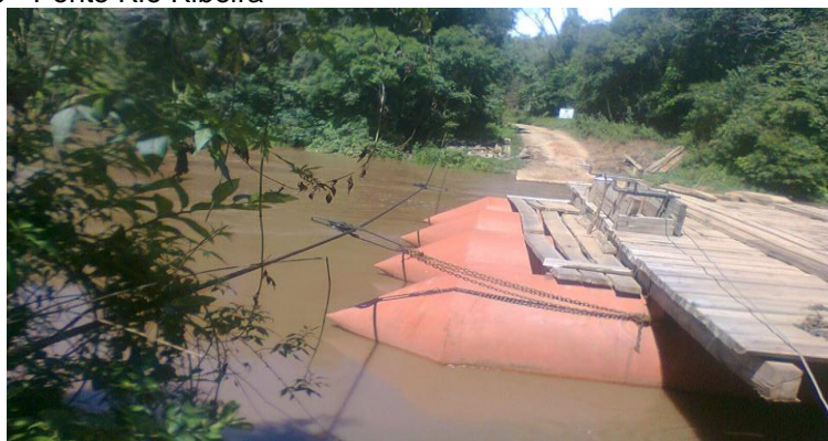
Figura 10 - Ponte Rio Ribeira
